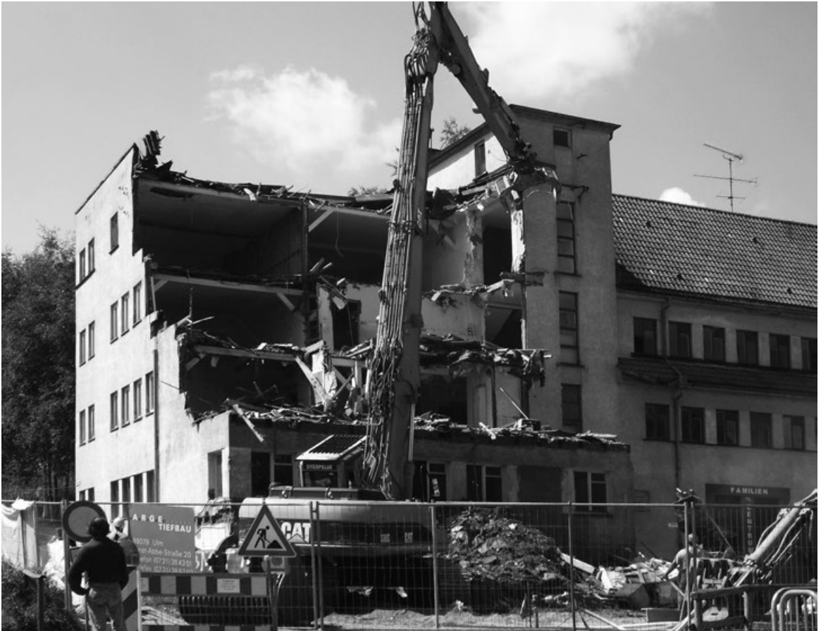
Der Abbruch des Gebäudes erfolgte im August 2009.
