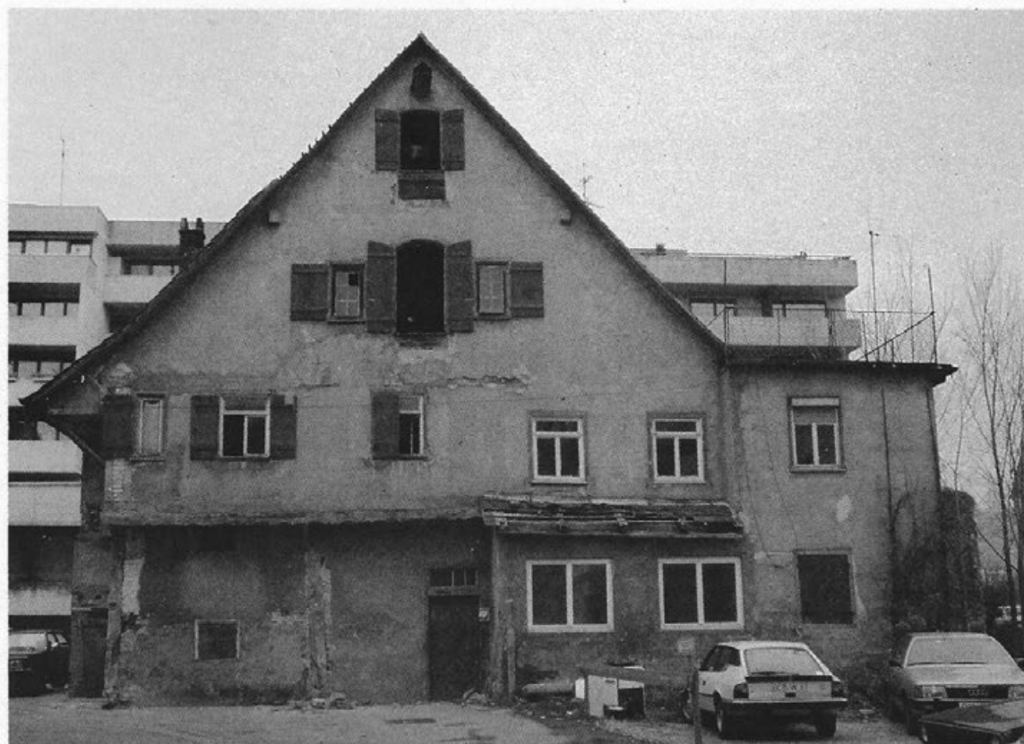
Blick auf die südliche Giebelseite, Zustand 1986
