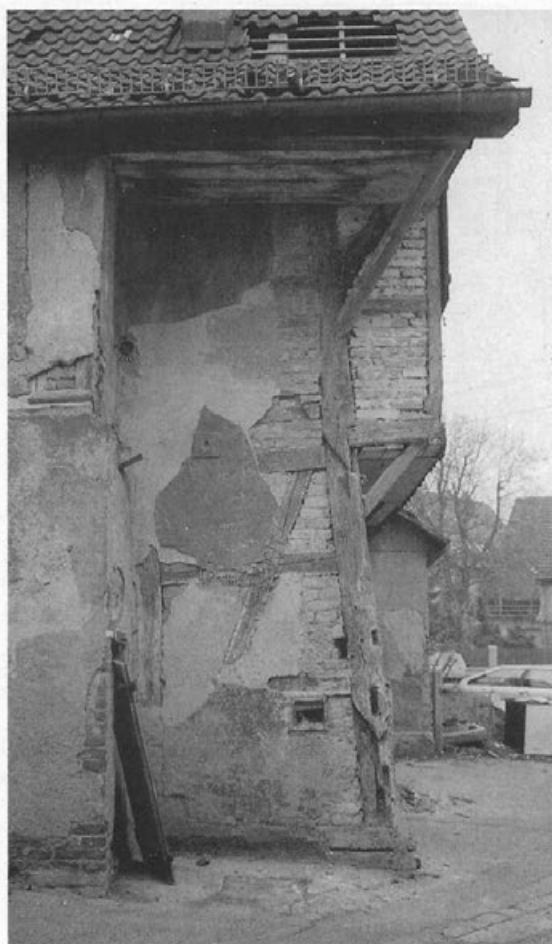
Blick auf die Südwestecke des Gebäudes, Zust. 1986
