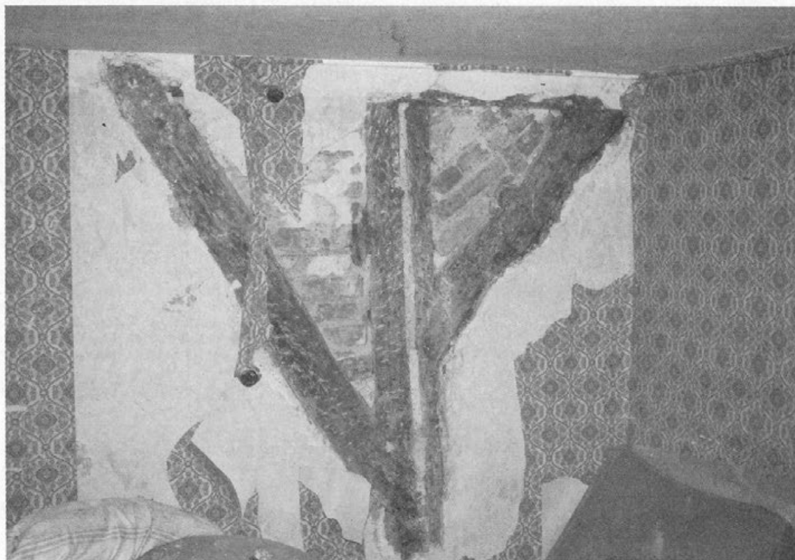
Freigelegte Fachwerkkonstruktion der Erbauungszeit im Inneren (Ständer, Rähm, Kopfband und Bug), Zustand 1986 Foto: Uhl
