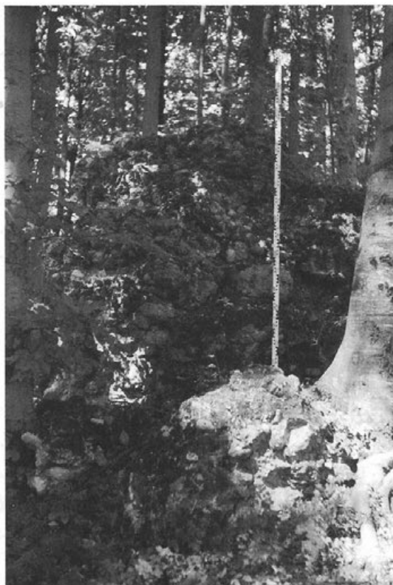
Neidegg, Mauerreste im Hofbereich, 1985. Foto: Uhl
