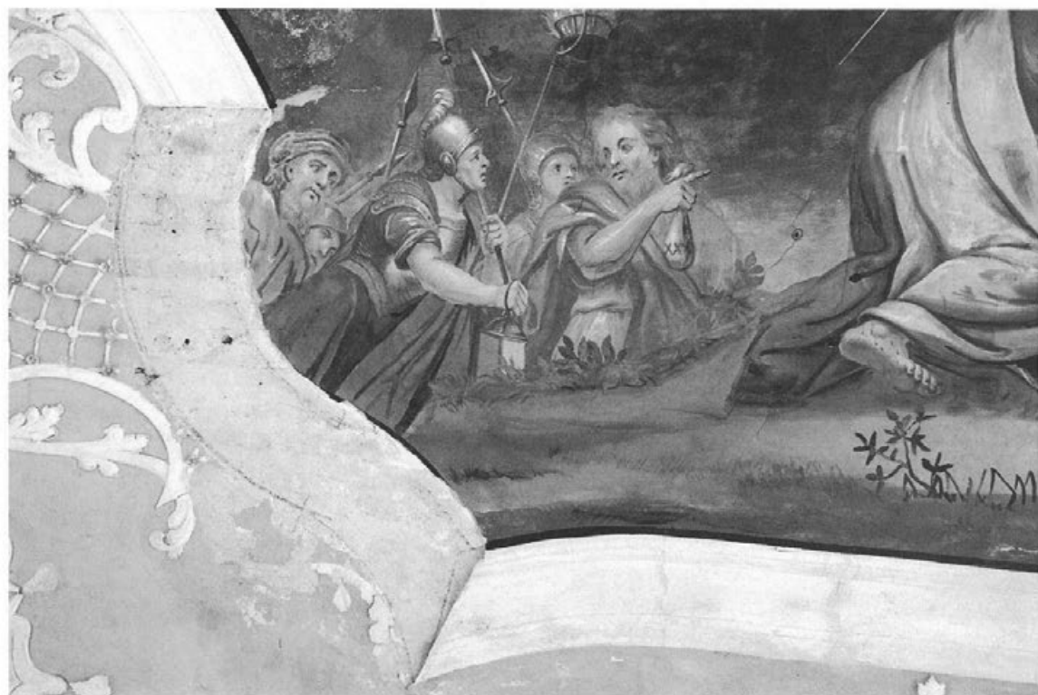
Die Deckenfresken haben Risse, der Deckenstück fällt in Platten herunter.
