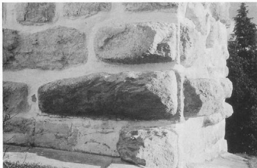
Unteressendorf, Mauerecke des Kirchturmunterteiles.
