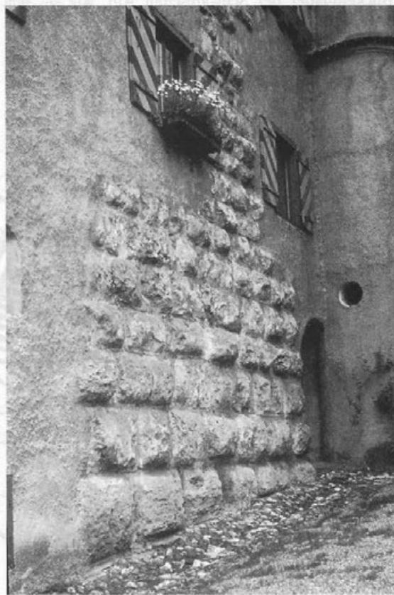
Grüningen, Buckelquadermauerwerk des Turmstumpfes.
