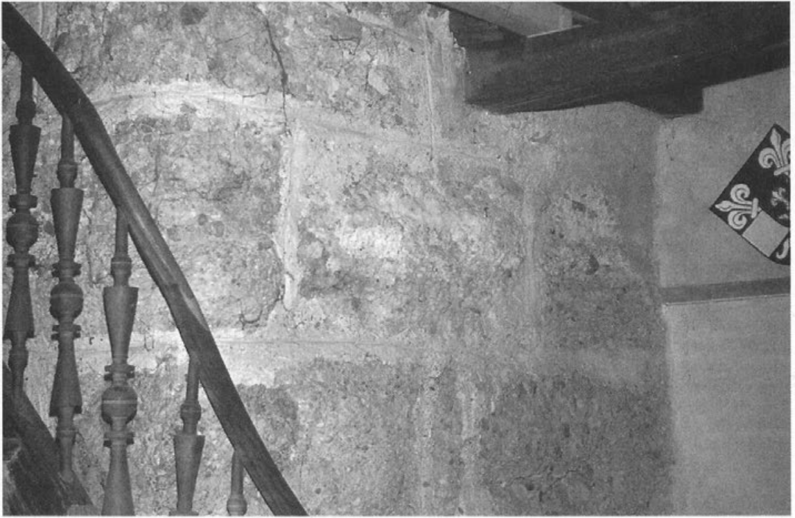
Warthausen, Buckelquaderecke im heutigen Ostturm.
