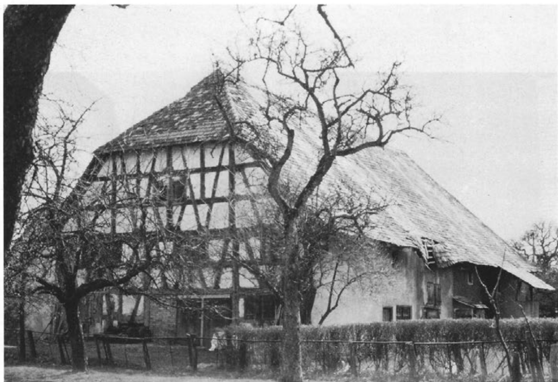
Der Bendelshof in Aulendorf – genauso steht er jetzt im Kreisfreilichtmuseum in Kürnbach. Natürlich mußten – wenn auch in geringem Rahmen – einzelne schadhafte Hölzer ausgewechselt werden. Auch wurde der hier sichtbare Schaden an der Traufe des Daches so nicht übernommen, sondern behoben. Erkennbar ist im Erdgeschoß der nachträgliche Einbau eines Garagentores. Fotos: E. Müller, Biberach
