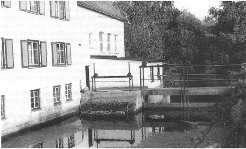
Wehr- und Staufalle für die Turbine in der Ölmühle zu Altheim.
