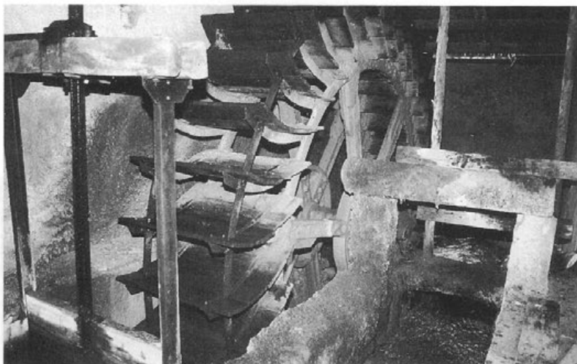
Wasserstube mit intaktem Rad in der Anlikers-Mühle zu Langenenslingen.
