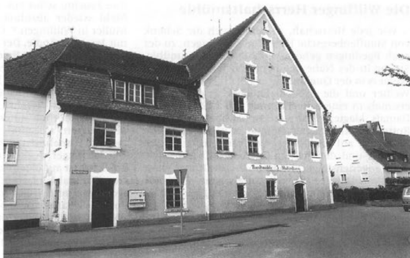
Mukensturmsche Kunstmühle oder Hintere Mühle in Andelfingen. Aufnahme: H. Gebele
