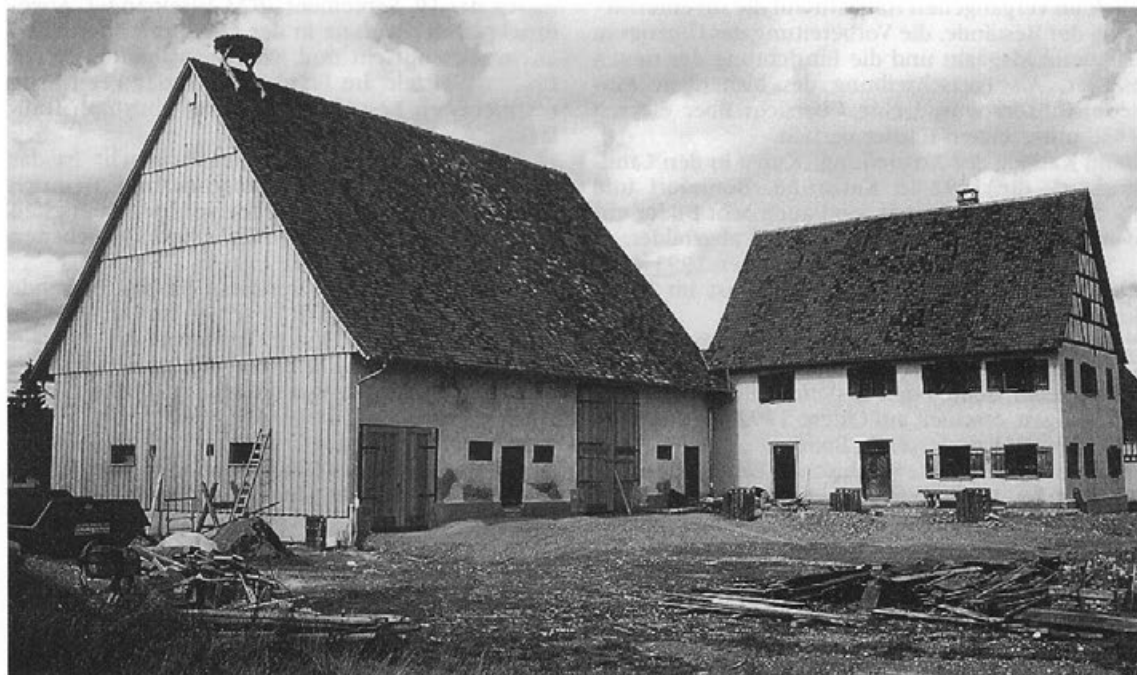
Wieder aufgebaut in Kürnbach ist der Untere Bauhof aus Betzenweiler.
