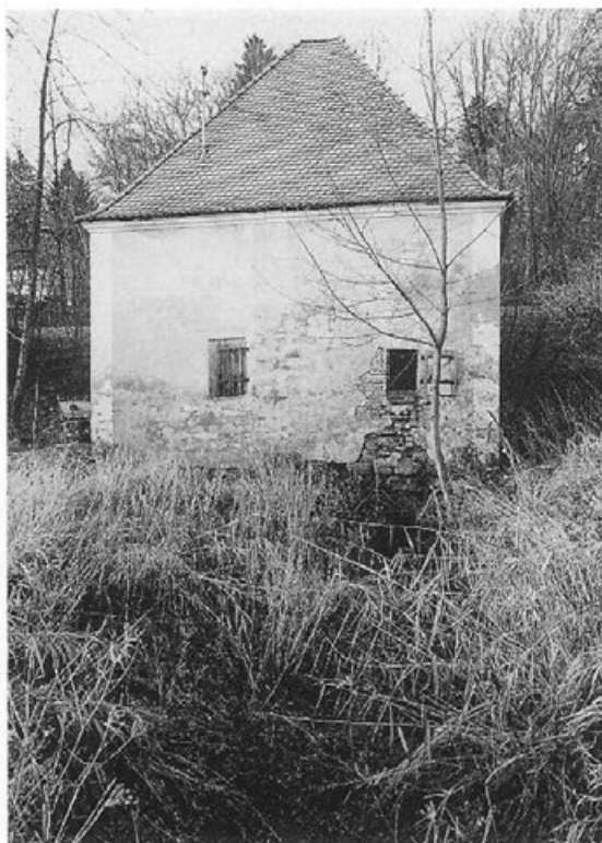
Das Wasserrad-Pumpwerk des Schlosses Warthausen nördlich von Biberach dient noch immer der Wasserversorgung des Schloßbereiches. Hinter dem offenen Fenster ruht das mächtige Wasserrad, das bis zum Dachtrauf reicht. Foto: L. D. Herbst
