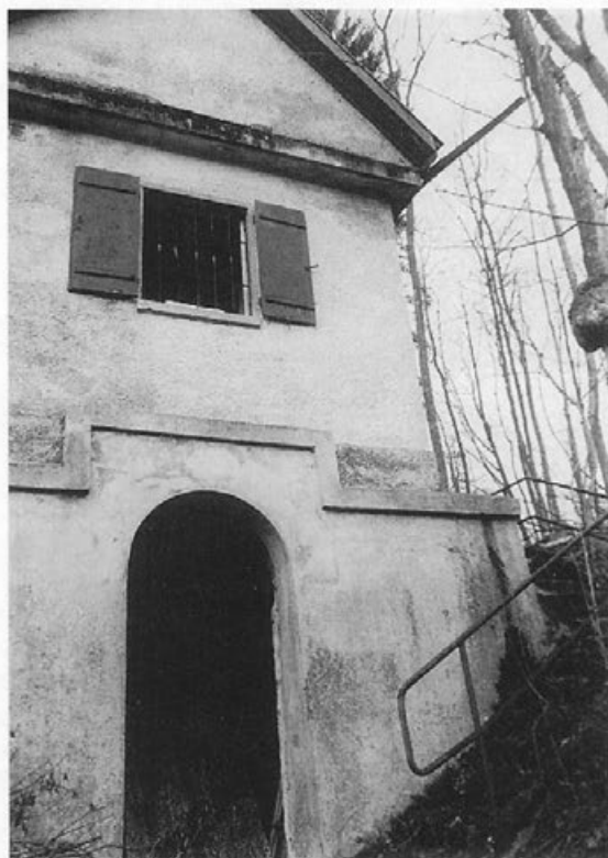
Mit wenig Aufwand könnte das Gebäude des Wasserrad-Pumpwerkes von Reute bei Bad Waldsee vor dem Verfall bewahrt werden und dem technischen Geschichtsunterricht dienen. Foto: L. D. Herbst
