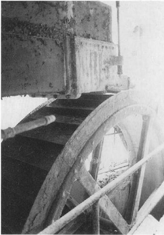
Die Triebwerkseinrichtung im Untergeschoß des Pumpwerkes. Foto: L. D. Herbst
