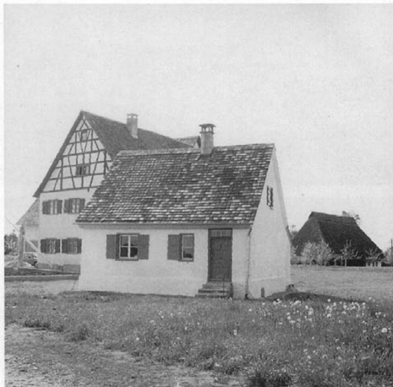
Das Stüble nach seiner Fertigstellung. Im Hintergrund links das Wohnhaus des „Unteren Bauhofs“. Foto: Joist, Kürnbach
