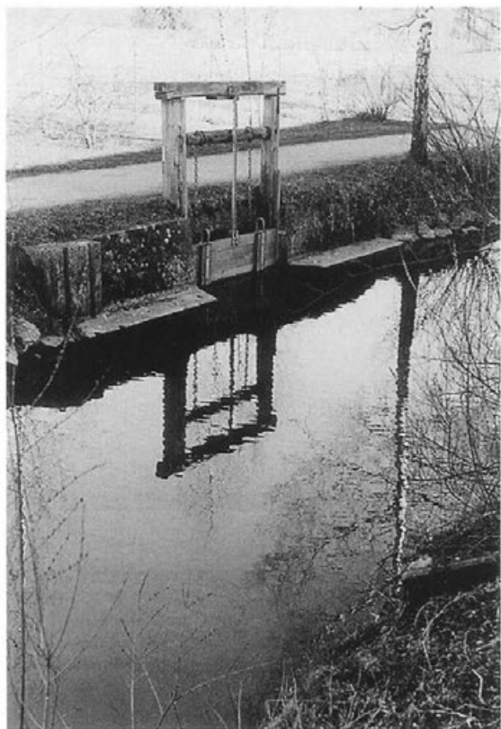
Der Fallenstock am Schwarzen Bach verbindet ihn mit der Angermühle an der Riß.
