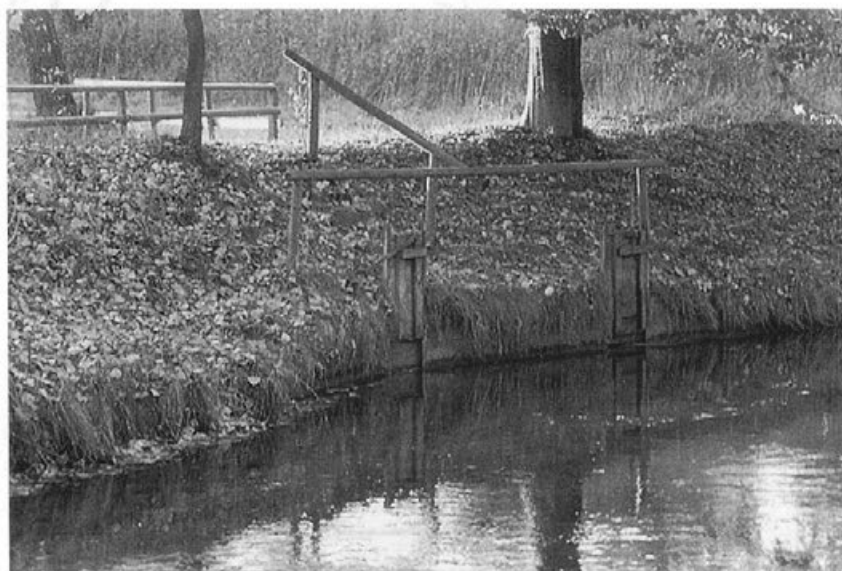
Die Ableitung des Schwarzen Baches erfolgt seit dem 15. Jahrhundert unter einem Rißdamm hinweg und wird mit Schützenklappen reguliert.
