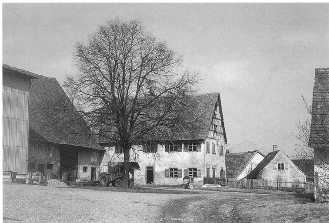
Abb. 7: Der Untere Bauhof am alten Standort mit dem dazugehörigen Stüble (rechts). Zustand am 2. April 1987. Foto: E. Müller, Biberach
