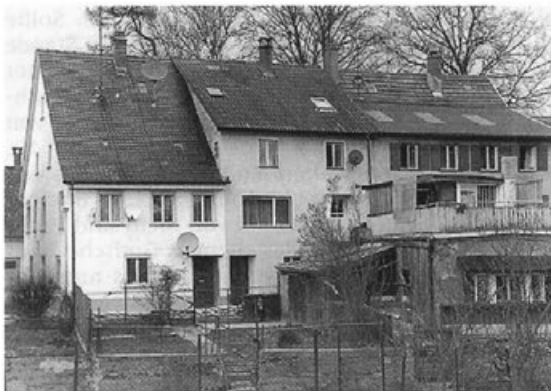
Aufnahme des Gebäudekomplexes Mühlvorstadt 24, 26, 28, wie er sich mit seinen zahlreichen An-, Um- und Ausbauten – zuletzt 1950 – 1995 vom Mühlbach aus zeigt. Foto: W. Aßfalg
