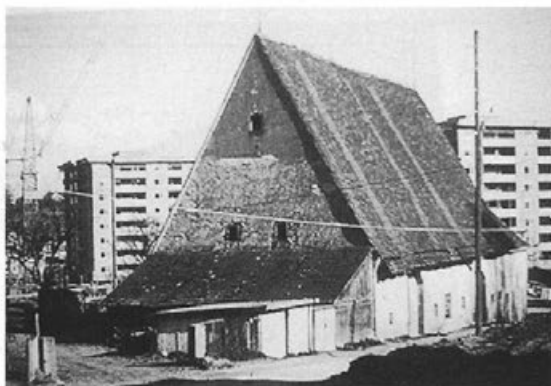
Die Steigmühle vor ihrem Abbruch.
