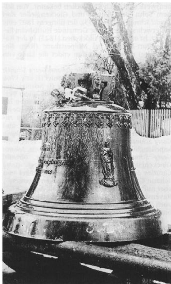
Die von Zoller in Biberach 1857 gegessene Glocke für die Rottumer Mauritiuskirche. Wie so viele Glocken, die er gegossen hatte, kehrte auch diese nach dem Zweiten Weltkrieg nicht in den Turm zurück. Die zwei Umschriften am Mantel sind nur fragmenthaft erhalten. „Maria unbefleckt empfangen, bitte für uns“, die andere ist unbekannt. Zwischen beiden Texten ein Reliefbild Maria auf einer Wolke, die Hände faltend zum Gebet, und St. Josef, auf dem linken Arm das Jesuskind tragend, in der Rechten einen Lilienzweig, auf der anderen Seite des Glockenmantels.
