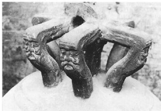
Die für Vollmer typischen Kronenbügel bärtiger Masken zum Aufhängen der Glocke hier an der Elferin in Biberach.
