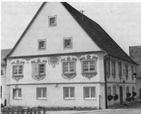
Die Gaststätte „Zur Linde“ nach gründlicher Renovierung.
