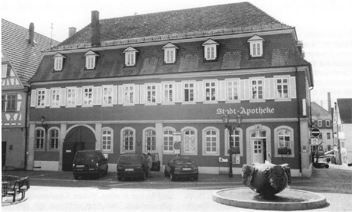
Bönningheim, Haus der Familie Brentano; Ansicht von Westen. Dieser stattliche Barockbau wird gelegentlich Anton Haaf zugeschrieben; doch liegen für dessen Mitwirkung oder gar Urheberschaft bislang keine Belege vor.
