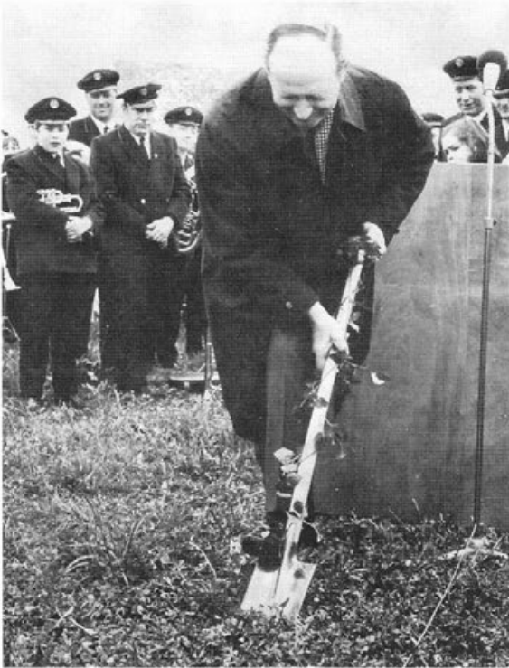
1. Spatenstich für das neue Kreisgymnasium Riedlingen am 6. Mai 1970 durch Ministerpräsident Dr. Hans Filbinger.
