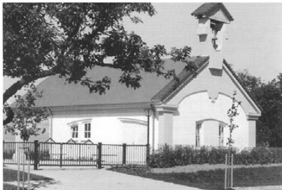
Die 1992 errichtete Leichenhalle auf dem Seekircher Friedhof.
