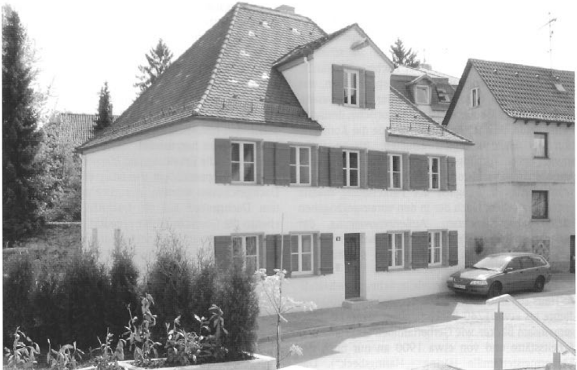
Das sanierte Gebäude Zwingergasse 16.
