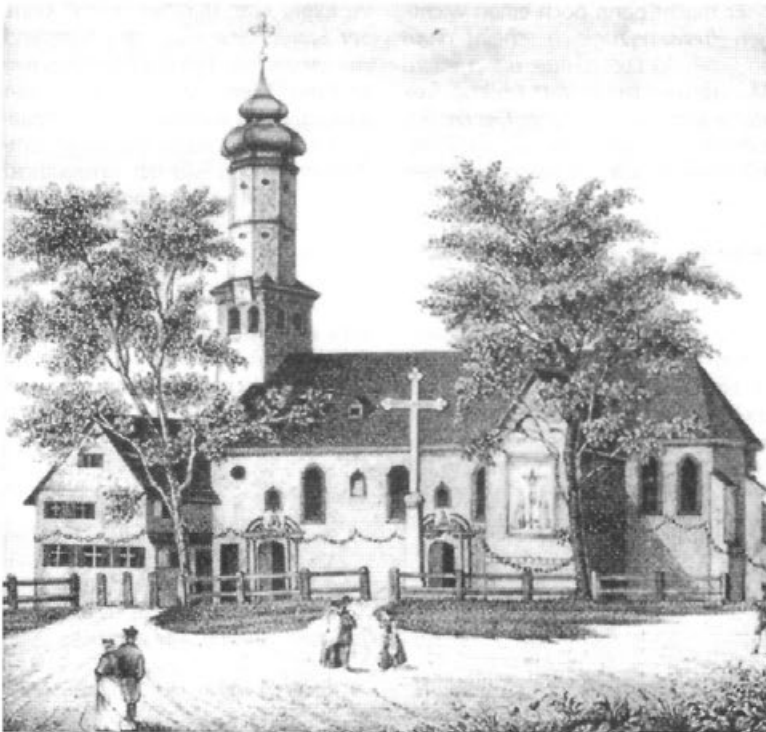
Die St.-Leonhards-Kapelle in Laupheim.
