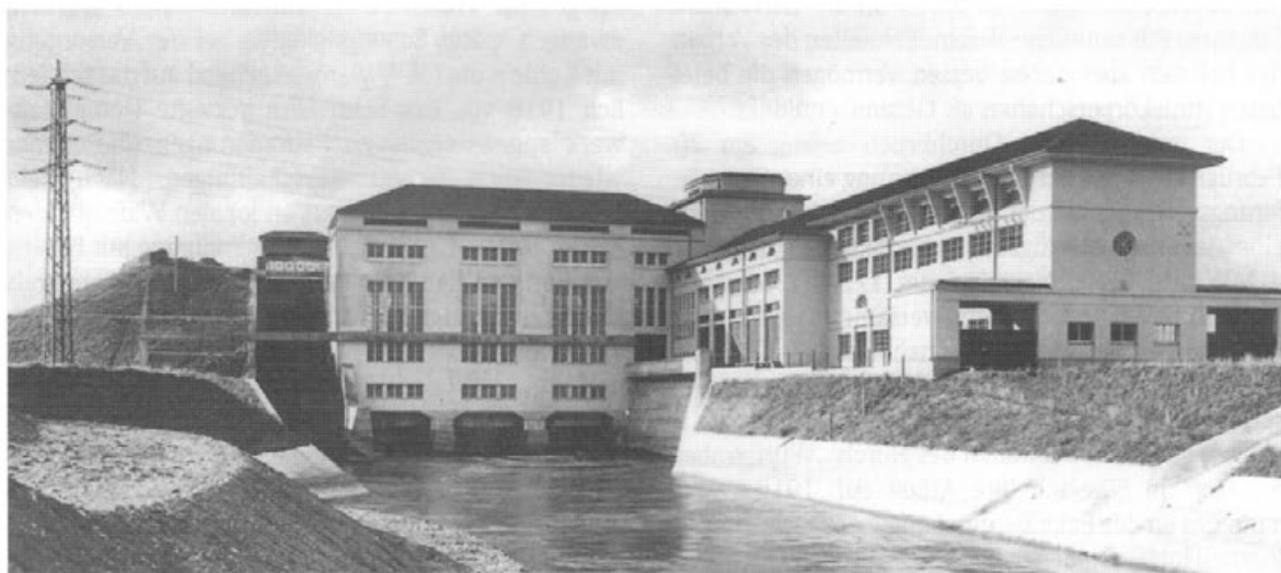
Illerkraftwerk Tannheim, Ansicht vom Unterwasser. Inbetriebnahme Januar 1923; Ausbauleistung 8360 kW, 1932 10 700 kW.
