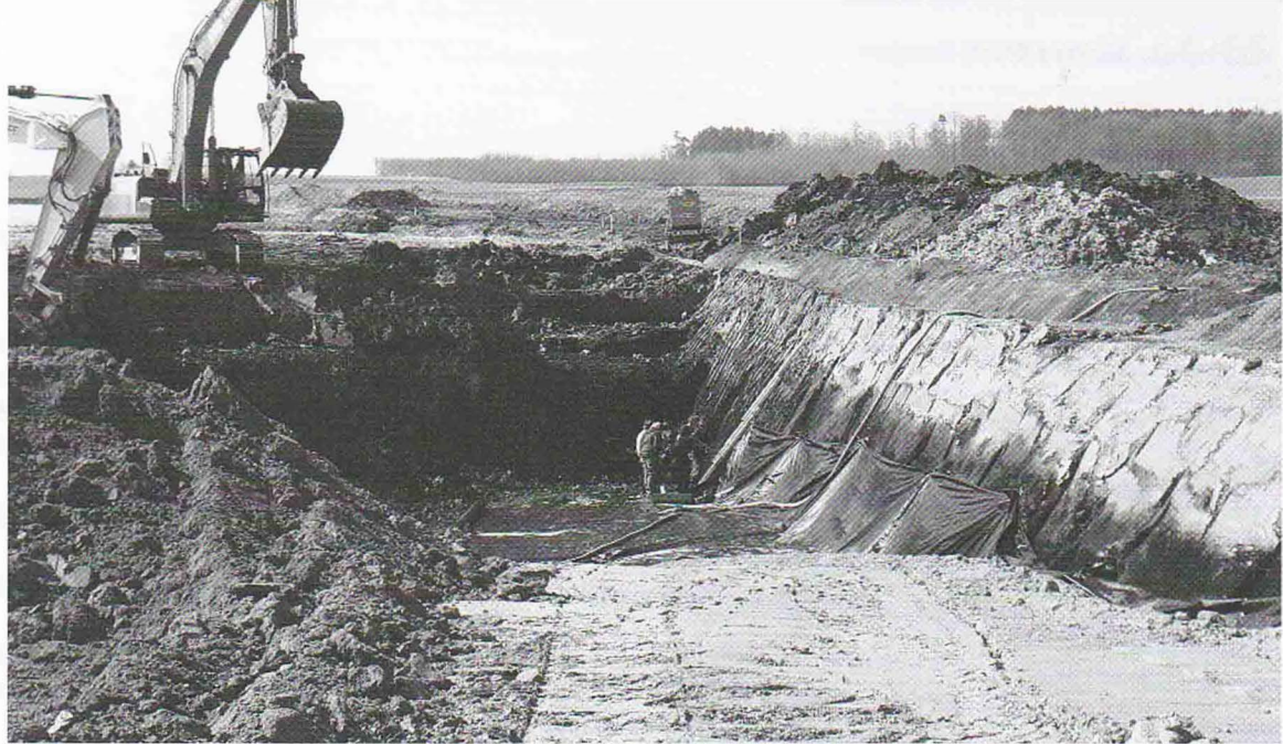
Abb. 1: Das Material musste während der laufenden Baumaßnahmen an der Nordumfahrung geborgen werden.
