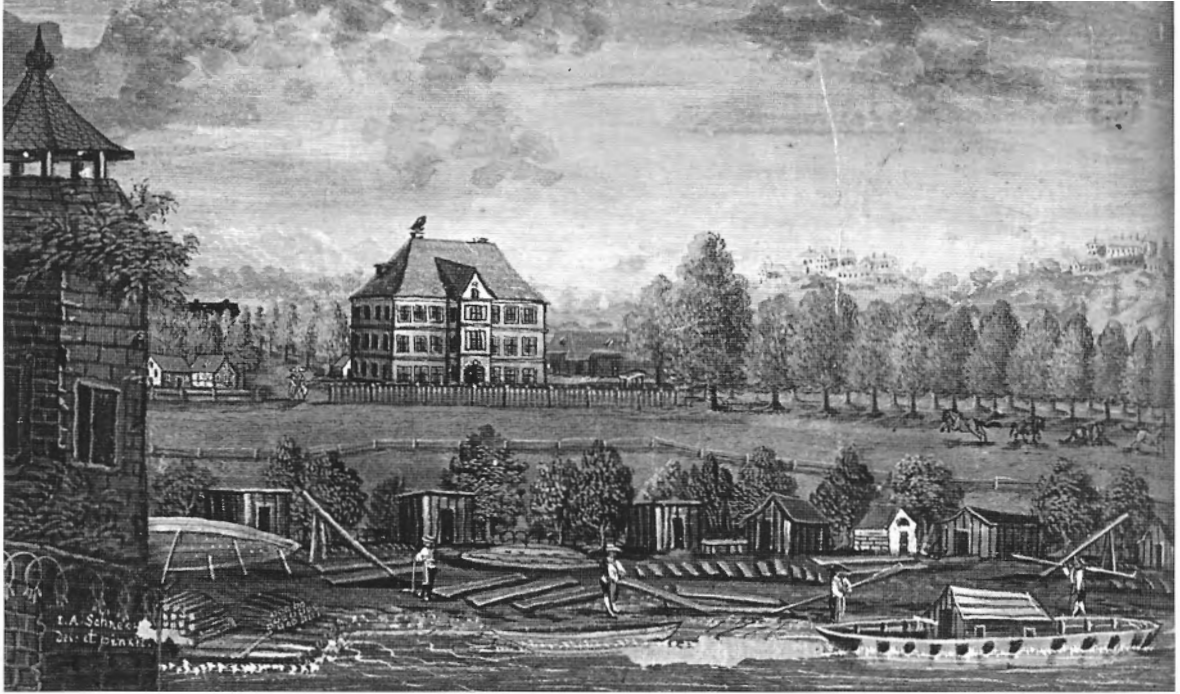
Von der Stadtmauer aus konnten die Auswanderer das Entstehen der Zillen auf den Schopperplätzen am gegenüberliegenden Donauufer beobachten.
