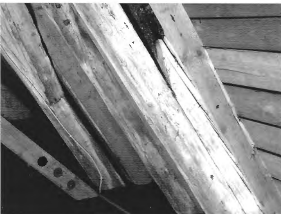
Abb. 5 Brandspuren im Dachgebälk.
