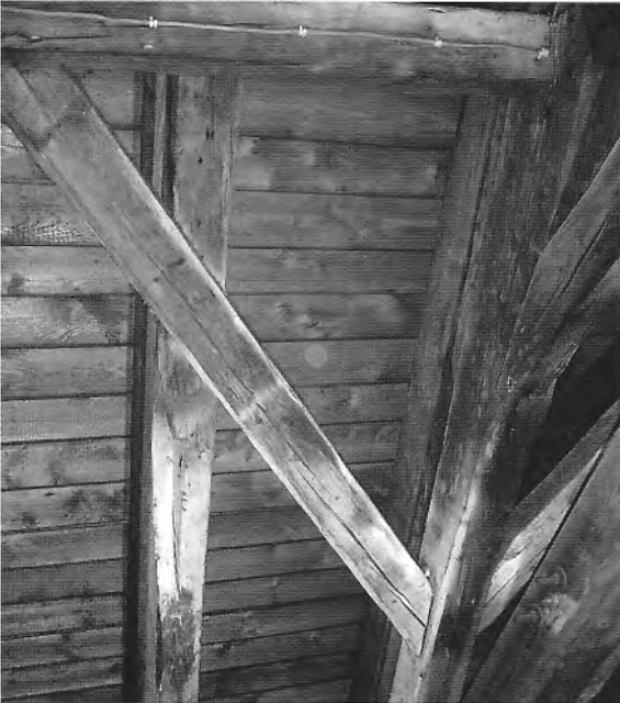
Abb. 3 Windverband zur Aufnahme der Windkräfte.
