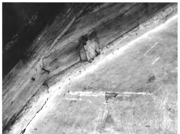
Abb. 6 Reste der Schalung der früheren Schiffsdecke.
