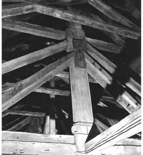
Abb. 2 Das Hängewerk im Schiff.
