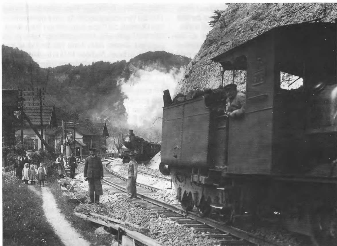
Bauarbeiten auf der Geislinger Steige um 1902.
