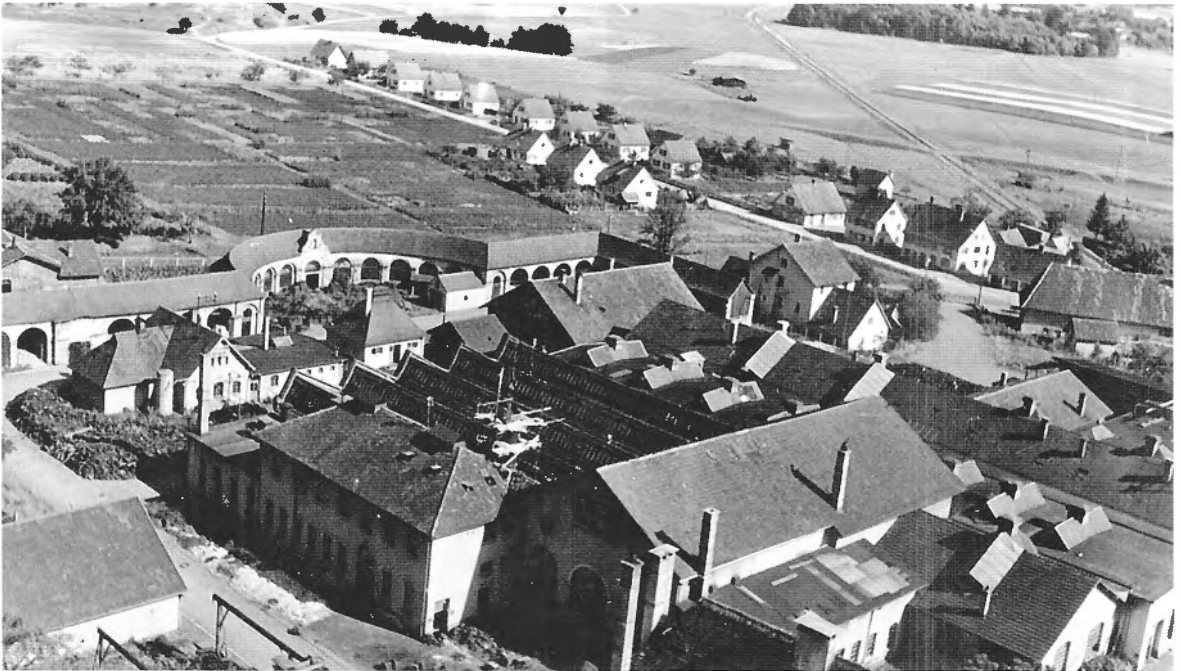
Werksbauten des Hüttenwerkes
