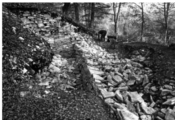
Abb. 11 Ergrabene Mauer auf der Alten Burg bei Langenenslingen.
