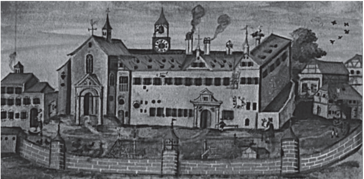
Westansicht der Gutenzeller Konventanlage um 1585 nach ihrem Umbau durch Äbtissin Maria Segesser von Brunegg. Klosterchronik, Bl. 40 b.
