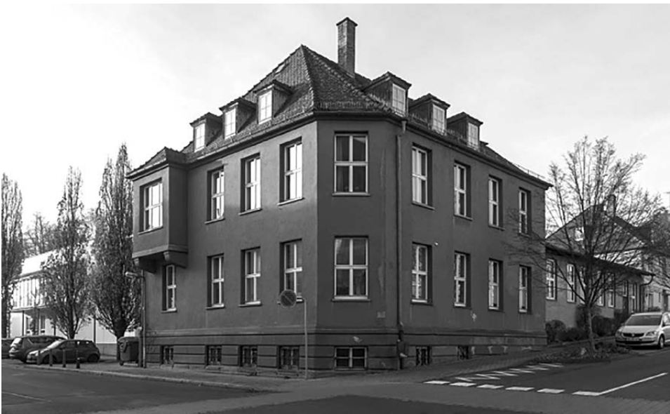
Wielandstraße 27, „Pestalozzihaus“, Zustand um 1900 und heutige Situation.
