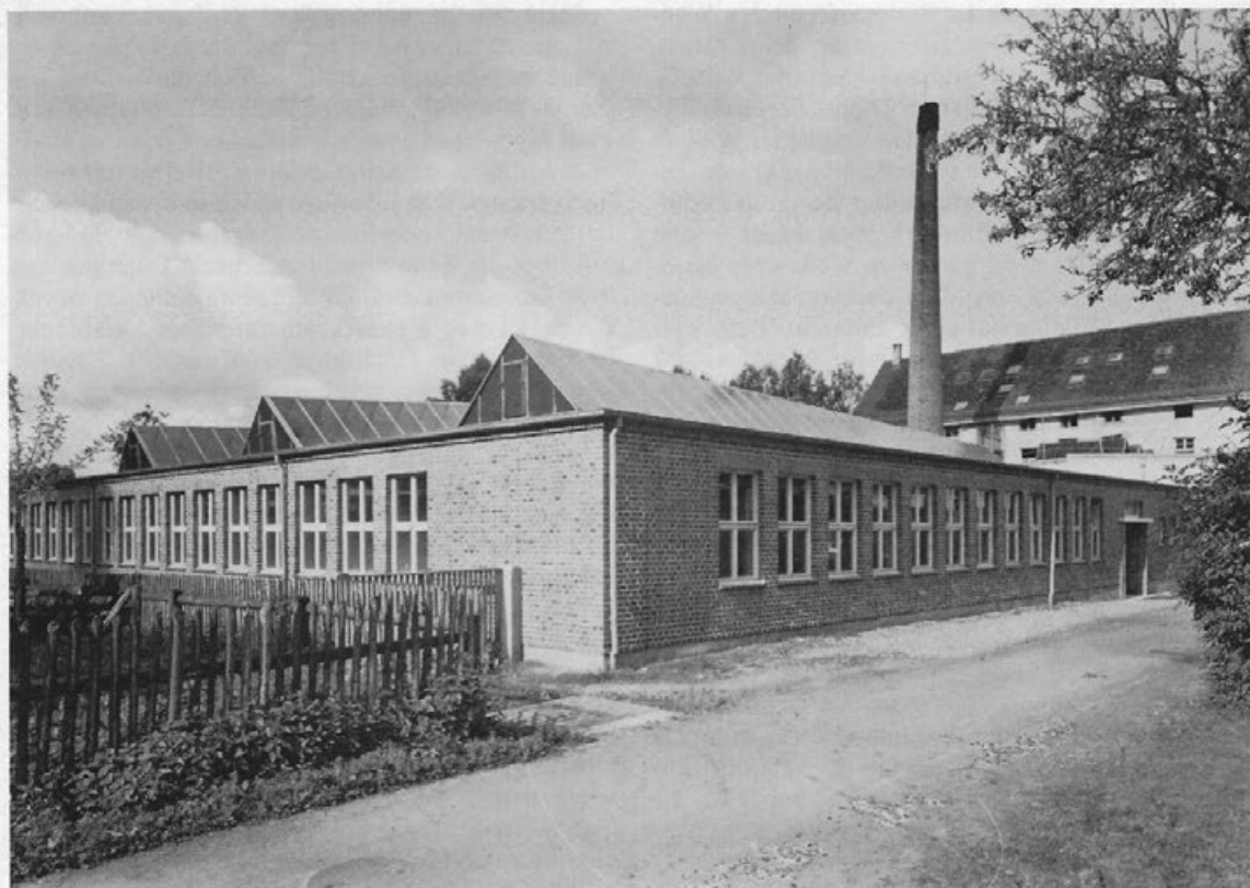
Ehemalige Seidenfabrik Schmitz. Neubau aus der Zeit zwischen den beiden Weltkriegen
