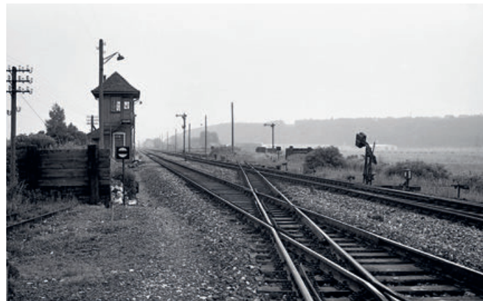
Die Gleisüberschneidung südlich Warthausen in Blickrichtung nach Norden. Links das Stellwerk 2 des Warthausener Bahnhofs. Alle Gleise sind durch die Ausfahr- und Schutzsignale des Bahnhofs gesichert, ebenso die Gegenrichtung durch die Einfahrsignale. Rechts der Bildmitte das Schutzsignal der Schmalspurbahn. Anders hätten Kreuzung und Sicherheitstechnik bei einer vollspurigen Strecke auch nicht ausgesehen. Foto (1964): Gebrüder Werner/Slg. Stadtarchiv Schwäb. Gmünd.
