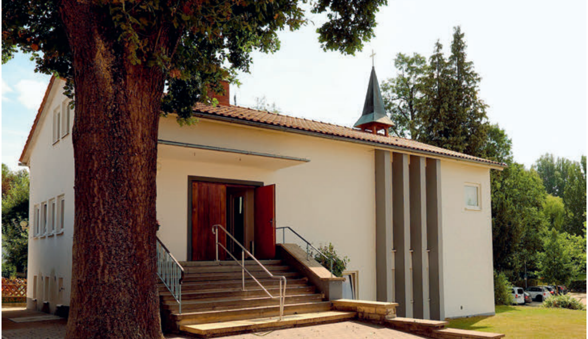
Am ehemaligen Standort der Synagoge befindet sich heute eine Kirche der Evangelisch-freikirchlichen Gemeinde, die 1962 erbaut wurde.
