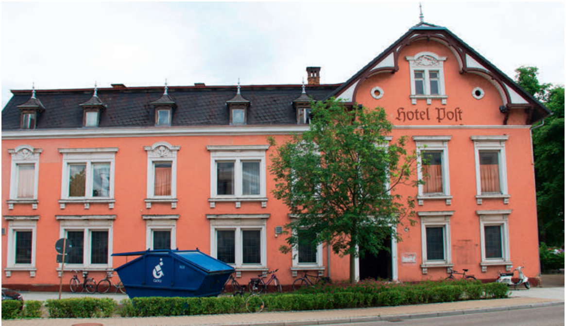
Hotel Post in Laupheim, Zustand 2018. Der vorgezogene hölzerne Dreipass, das Prunkfenster im Giebel und die Pinakel am Dach und den Gauben sind charakteristisch für den „Heimatstil“ der 1860er-Jahre. Über dem Prunkfenster das württembergische Wappen aus der Zeit als königlich-württembergische Poststation.
