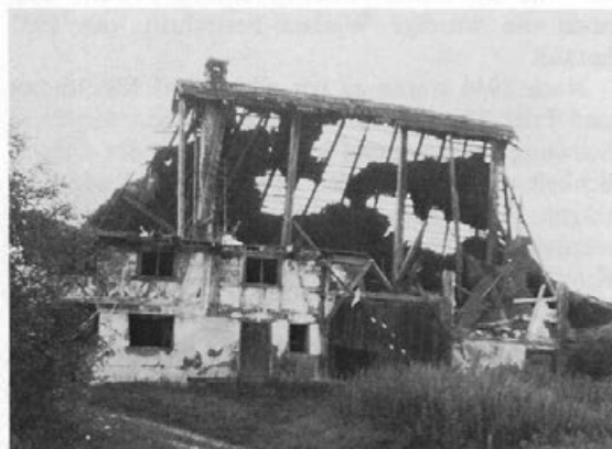
Die Hueb vor dem Abbruch 1971 Foto: Prof. Schmid
