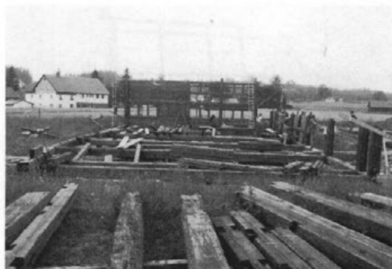
Das Ständergerüst wird über den Grundschwelle aufgerichtet. Foto: M. Gerber
