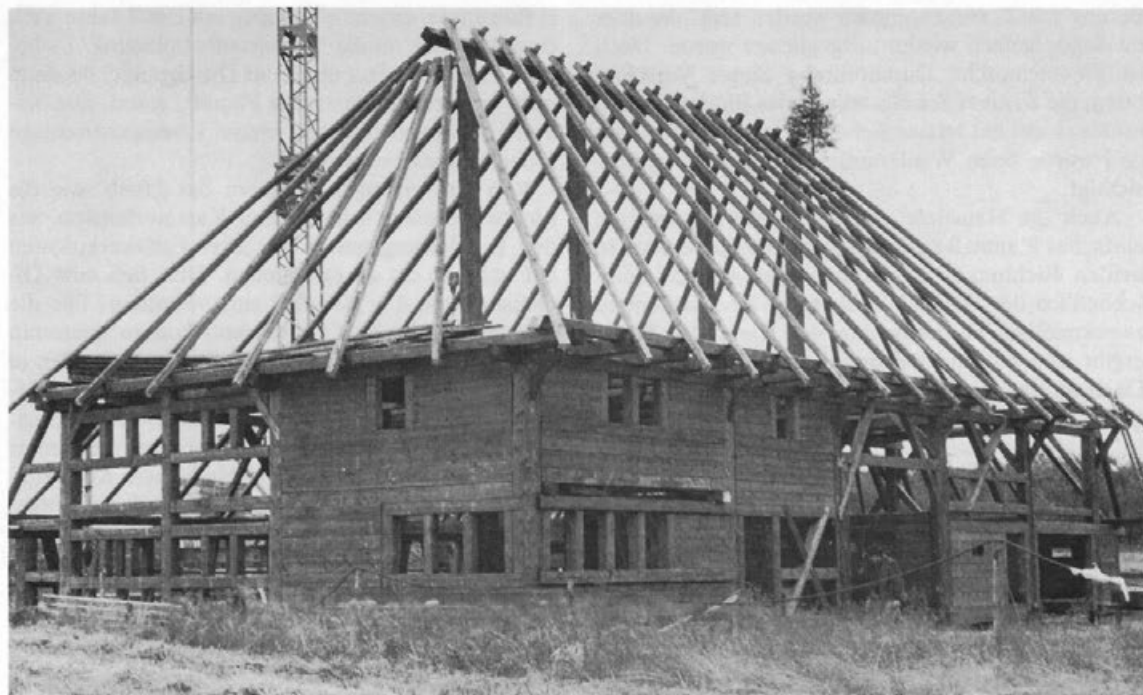
Die Holzkonstruktion steht und läßt den Blick in den Dachraum mit seinen vier Hochsäulen frei.
