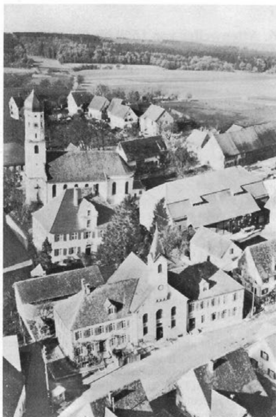
Attenweiler, Ortsmitte nach einer Postkarte aus den fünfziger Jahren. Deutlich erkennt man die Entwicklung des evangelischen Gemeindezentrums auf dem Gelände der ehemaligen Zehntscheuer.
