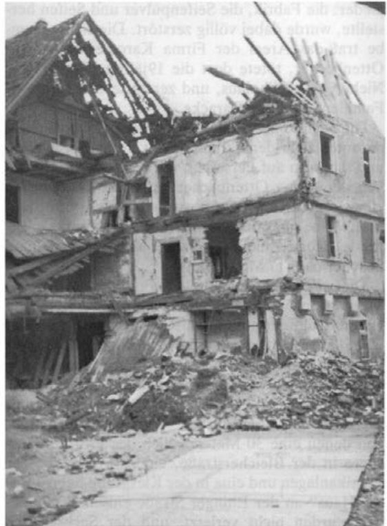
Eckhaus Pfluggasse – Ulmer-Tor-Straße (Haus Kallenberg). Die Trümmer sind einigermaßen weggeräumt, die offene Kanalisation (vgl. Seite 25) ist wieder zugedeckt.
