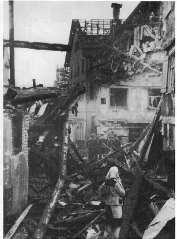
Aufräumarbeiten bei der Stadtfärbe. Gegenüber Metzgerei Huber.
