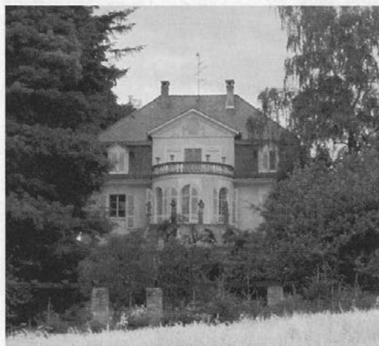
41 Rot, „Villa Fugger“
