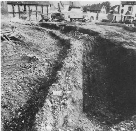
Abb. 2: Beim Primäraushub für die Tiefgarage wurde das Fundament der Zwingermauer freigelegt und später ausgebaggert.
