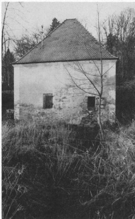
Das Pumpwerk der Wasserversorgung Schloß Warthausen. Hinter dem rechten Fenster ruht das Wasserrad, dessen Höhe bis zur Traufkante reicht (Januar 1988).
