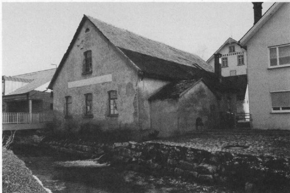
Das Mühlenensemble Grenzenmühle/Ölmühle Zwerger mit deutlich sichtbarer Radstube (Februar 1988).
