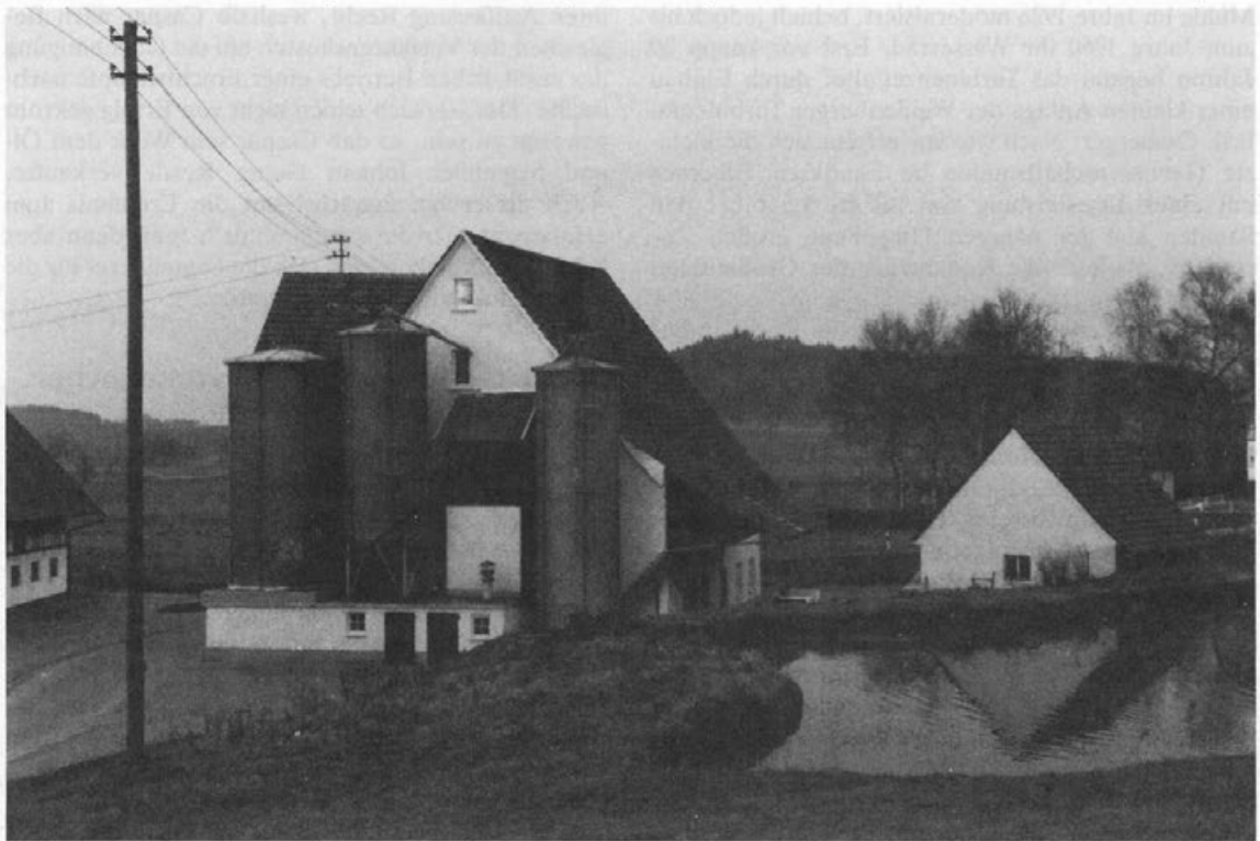
Die Rißmühle am Mahlweiher Winterstettendorf: Achenbach-Silos haben den Platz der alten Wasserräder eingenommen. Darunter das flache Turbinenhaus (Januar 1988). Fotos: L. D. Herbst / B. Winghart
