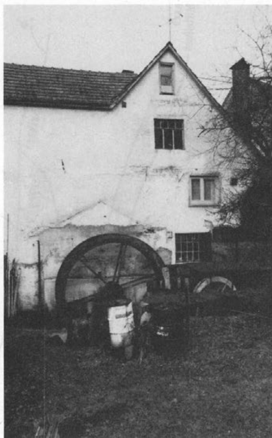
Die Radgeschwister der Hammerschmiede Kloos in Fischbach. Die Hauswand läßt erahnen, daß eine Radstube dereinst das Hammerrad vor Frost und Eis schützte (November 1987).
