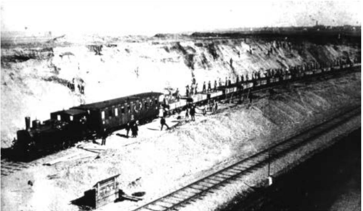
*Böschungsarbeiten zwischen Laupheim und Burgrieden mit Einsatz eines Baustellenzuges zur Ab- und Anfuhr von Baumaterial.*
