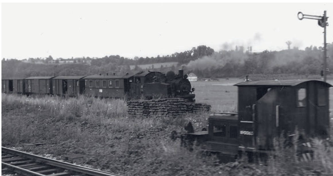
Eine Szene von 1961: Der Fotograf sitzt im vollspurigen Zug Friedrichshafen – Ulm. Vor dem Schutzsignal vor der Kreuzung muss hier der Schmalspurzug ausnahmsweise warten. Vorne rechts die erste eigene vollspurige Rangierlokomotive in Warthausen, eine der ersten Kleindieselloks der Reichsbahn überhaupt – was zeigt, wie wichtig der Bahnhof Warthausen durch das Rangiergeschäft für die Ochsenhausener Strecke war.
