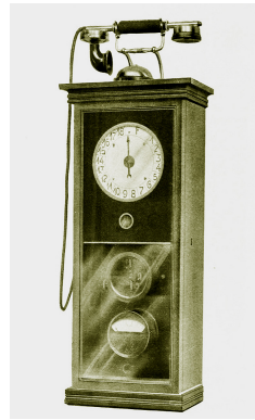
Abb. 1: Öffentlicher Feuermelder aus Biberach (1920); Abb. 2: Wecker in Nussbaumholzkasten (1920); Abb. 3: Feuermelderzentrale mit Fernsprecheinrichtung, Zeiger-Empfangsapparat (1920). (Stadtarchiv); Abb. 4: Wecker aus dem Jahr um 1930.
