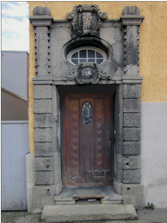
Abb. 9 Am Bismarckring 26. Ein historistisches Portal von 1907, eines der wenigen in Biberach. Zusammen mit dem wuchtigen Erker im 1. Stock erinnert das Portal an eine alte Burganlage.
