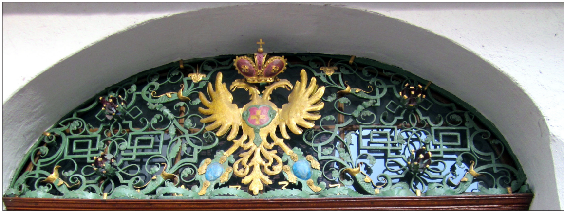
Abb. 11: Katholisches Pfarramt Kirchplatz, Oberlicht. Sicherheit vor Einbrechern war auch in alter Zeit von großer Bedeutung. So waren Haustüren, oft aus Eiche, bewehrt mit starken Schlössern und kräftigen Riegeln. Flur und Treppenhaus dahinter waren also dunkel. Obligatorisch war also ein Oberlicht, das wie hier im Barock reich geschmückt war.
