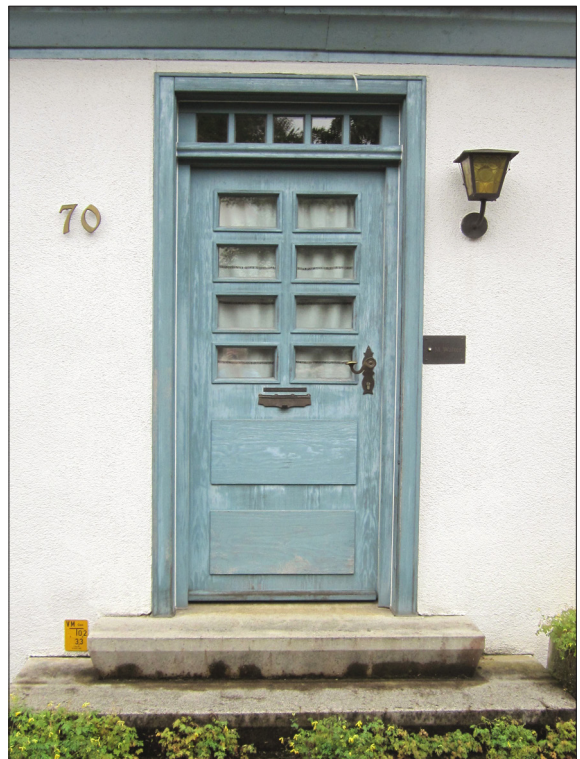
Abb. 12 Scheffelstraße, Galgenberg. Diese schlichte und einfache Tür stammt aus der Siedlung Guido Schmitz, die den Galgenberg im Westen und Süden umschließt. In dieser historisch bedeutsamen Siedlung wurde versucht, nach den schlimmen Jahren des 1. Weltkriegs auch Nichtbegüterten eine Heimat zu schaffen.
