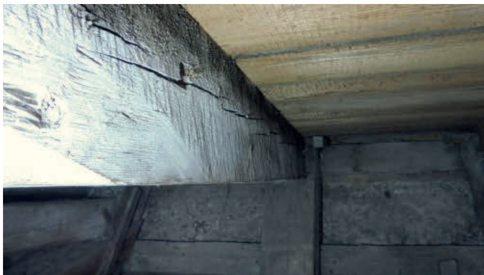
Abb. 2: Spuren der Kransäge. (Foto von Bernd Otto)
