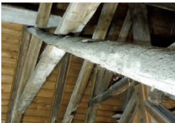
Abb. 5: Baumkante bei Scherenhölzern. (Foto von Bernd Otto)
