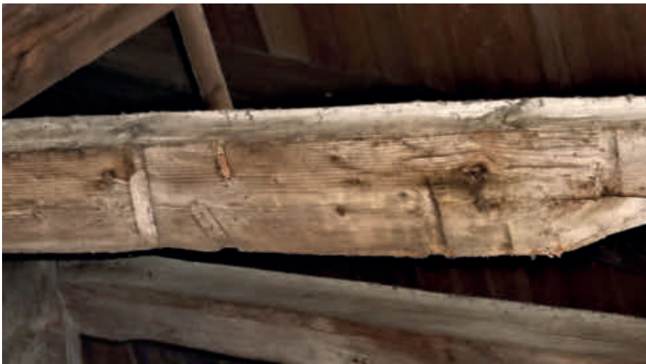
Abb. 3: Abdrücke von (Löffel-)Bohrern an den Scherenhölzern. (Foto von Bernd Otto)
