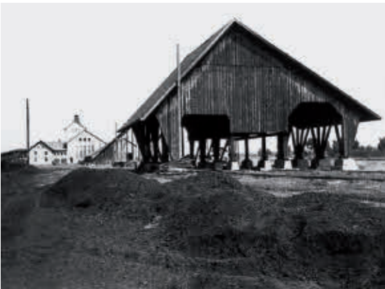
Die Brikettfabrik etwa 600 m hinter dem eigentlichen Torfwerk. Die Betonsöckel der Verladerampe sind heute noch zu erkennen. Aufnahme ca. 1950. (Sammlung Walter Hermanutz)
